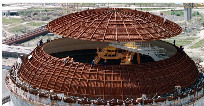
Dohromady konstrukci kontejnmentu vyztužuje 132 ocelových lan. Každé by přitom udrželo tisíc osobních automobilů, je totiž předepjaté silou tisíc tun. Tloušťka lana je 20 centimetrů a je spleteno z 478 ocelových drátů. Délka se pohybuje od 95 do 190 metrů.
